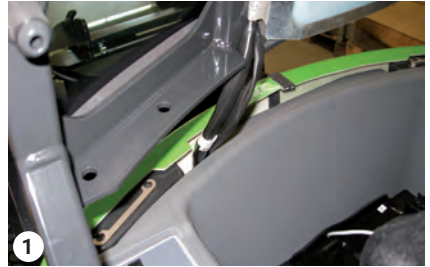
Leitungen nach oben ziehen
