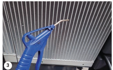
3 Druckluftreinigung des Kühlers
