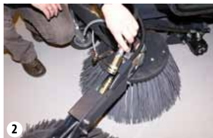
Montage der Hydraulikschläuche + Wasserschläuche am Seitenbesen
