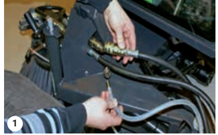
Montage der Hydraulikschläuche + Wasserschläuche am Frontkuppeldreieck
