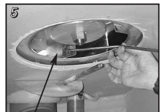
Reinigung der Turbine
