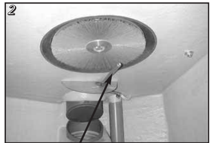
Wasserdüse im Saugtank
