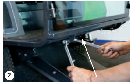
Bolte under bundpladen
