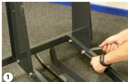
2 bolte på tankstativet
