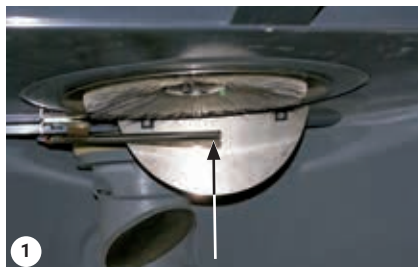
Kontrol af rotationsfilter og turbine
