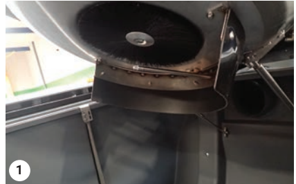
Kontrol af rotorfilter og turbine
