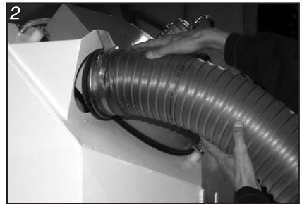
Sugeslangen afmonteres
