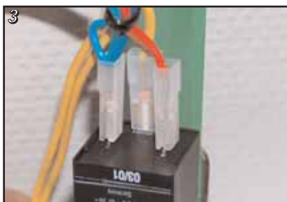
Kontroller stikkene på relæet
