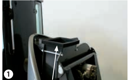
Sustitución de la junta de la turbina de aspiración
