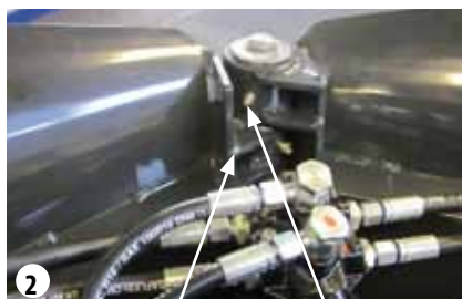
Colocación de las boquillas de lubricación
