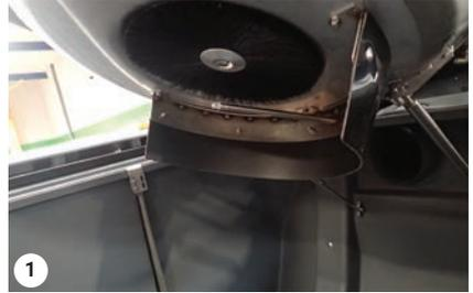
Comprobación del filtro rotativo y de la turbina
