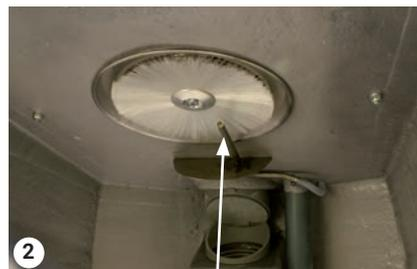
Boquilla pulverizadora del colector
