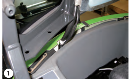
Vedä kaapelit ulos
