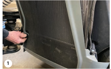
1 Pääsy jäähdyttimen ja ilmastoinnin lauhduttimeen
