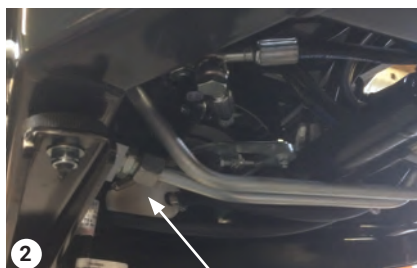
Filtre à carburant
